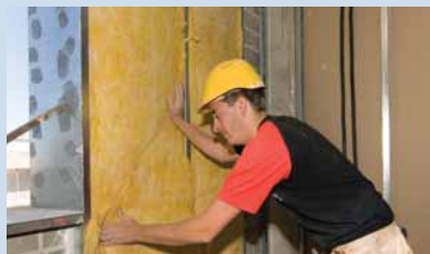
URSA GLASSWOOL P0081- Aisl. acústico en tabiques y medianeras con entramado metálico.
